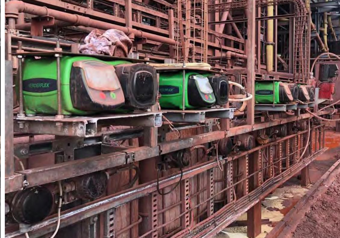
Die Verderflex Vantage 5000 ist mit ihrem sanften, rückflussfreien, peristaltischen Funktionsprinzip ideal für die Dosierung präziser Fördermengen geeignet.
